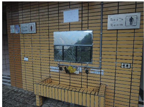
廁所洗手台、乾淨整潔
