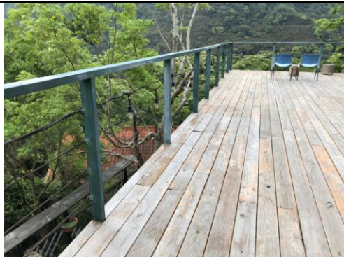
↑ 平台地板使用南方松木板
